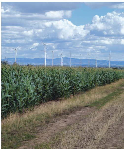
Blick von Obersülzen über den Stahlberg auf den bereits bestehenden Windpark. Genug ist genug! Quelle: Privat.
